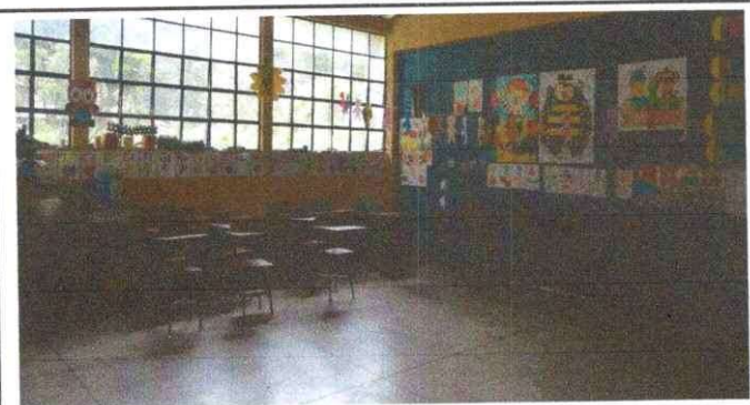
Foto 3: Vista de la situacion actual de aulas, se puede observar piso de cemento a piso porcelanato.
