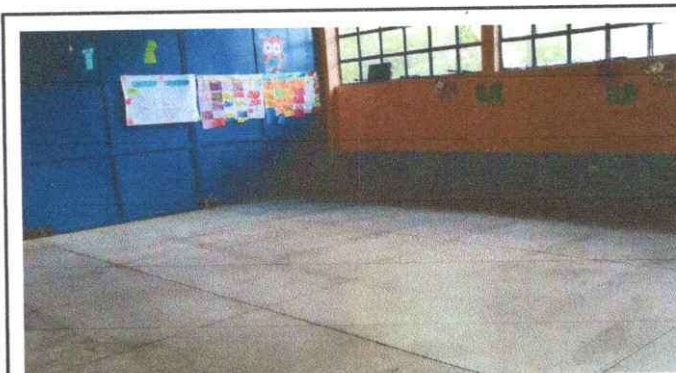
Foto 4: Vista interna de la situacion actual de piso de los modulos de aulas, dentro de los cuales se instalara piso porcelanato.
